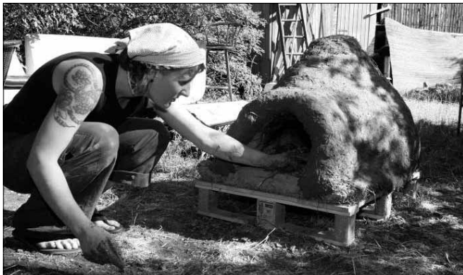
Bewohnerin des Bauwagenplatzes am Ende der Kiefernstraße baut aus Stroh, Lehm und Erde einen Backföhen
